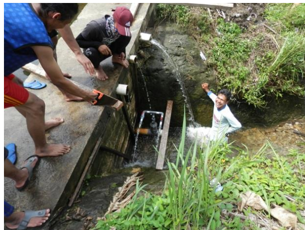
Gambar 8 Penyiapan saluran air bertekanan dari bendungan ke pompa hydram
