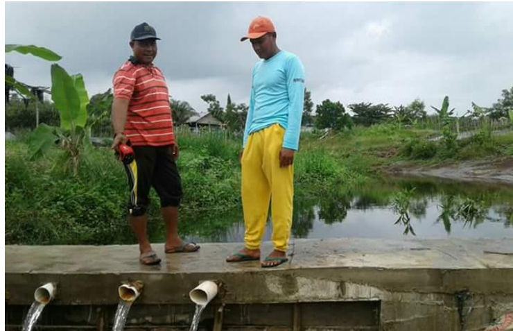
Gambar 5 Pembangunan bendungan dengan menggunakan teknik pengecoran
