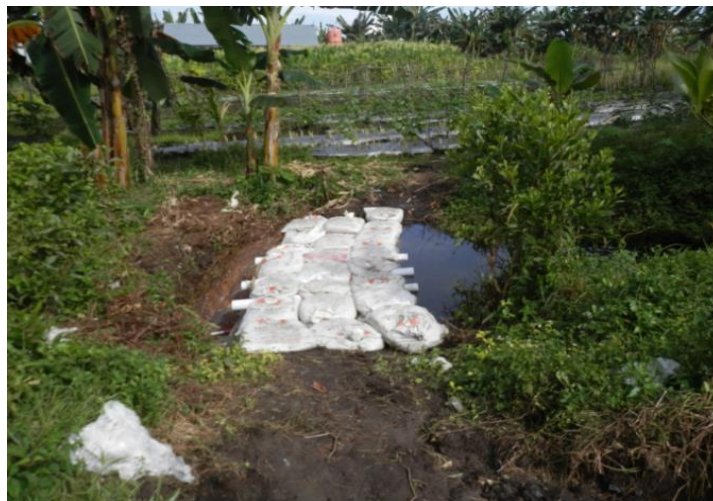
Gambar 6 Pembangunan bendungan dengan menggunakan karung berpasir
