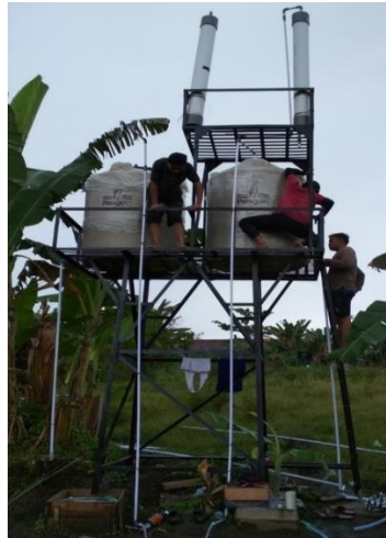
Gambar 10 Pembangunan Tower Reservoir
